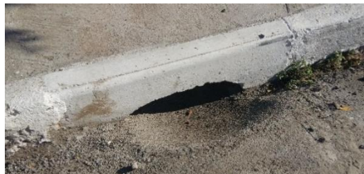
Figura 5 - Detalhe rebaixo na Boca de Lobo
