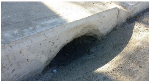
Figura 5 - Detalhe rebaixo na Boca de Lobo
